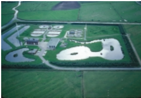
Kläranlage im Grünen
