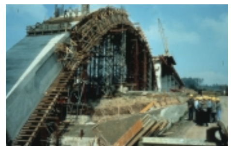
Stahlbetonbrücke im Bau
